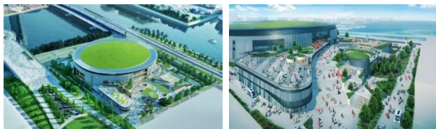
「TOKYO A-ARENA PROJECT」
